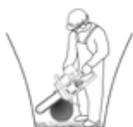
Gennemskæring med et snit - kræver mindre plads
